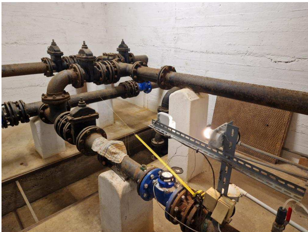
Foto 7: Vodojem – armaturní komora
